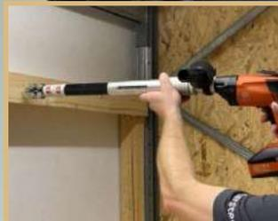
Einfaches Entfernen der Schraube
