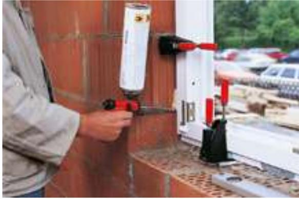
■ Für schnelles, exaktes Ausrichten und Fixieren von Fensterrahmen
