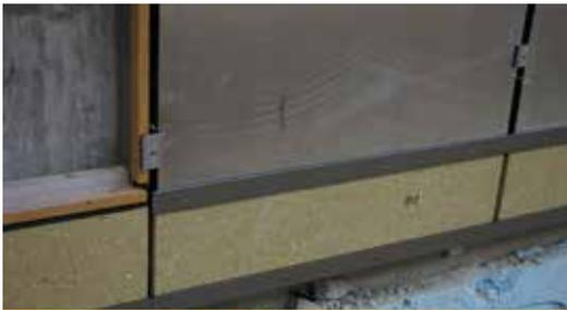
Konstruktive und dämmende Anwendung in der Fassade
