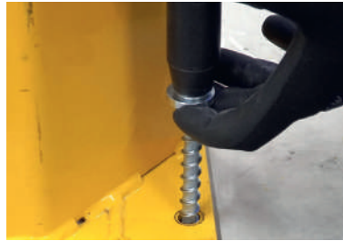
2.) Betonschraube mit Verfüllscheibe einschlagen, bis die Verankerungstiefe h_{nom} erreicht ist.
