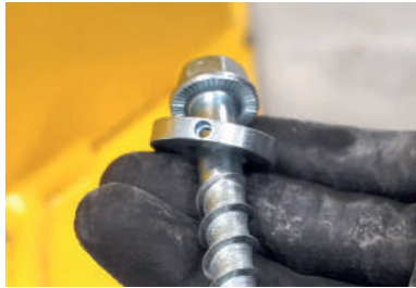
1.) Passende Verfüllscheibe zusätzlich zur Betonschraube montieren.
