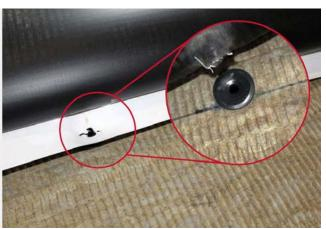
einen Befestigungspunkt gewirkt hat, zu groß war. Eine Reduzierung des Befestigerabstandes reduziert die auf einen Befestigungspunkt wirkenden Lasten und somit auch das Risiko eines Schadens.
