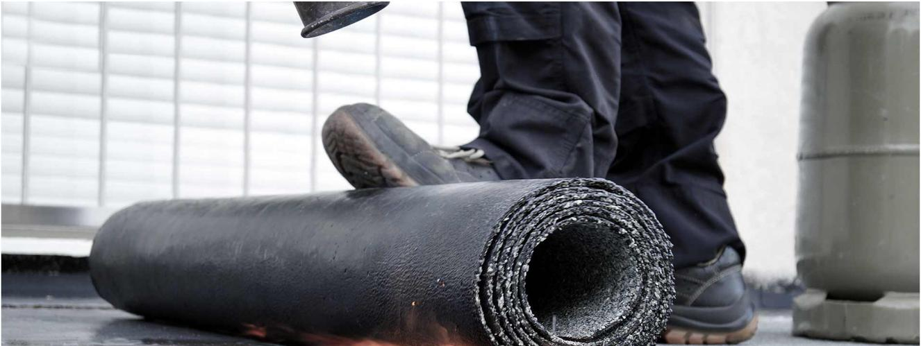
Bei der Lagesicherung der Dachbahn durch geklebte Bitumendachbahnen besteht immer das Risiko eines Brandes. Dem Brandschutz muss dabei besondere Aufmerksamkeit geschenkt werden, zudem ist es nicht auf allen Baustellen möglich, mit einem Brenner die Bitumen-
