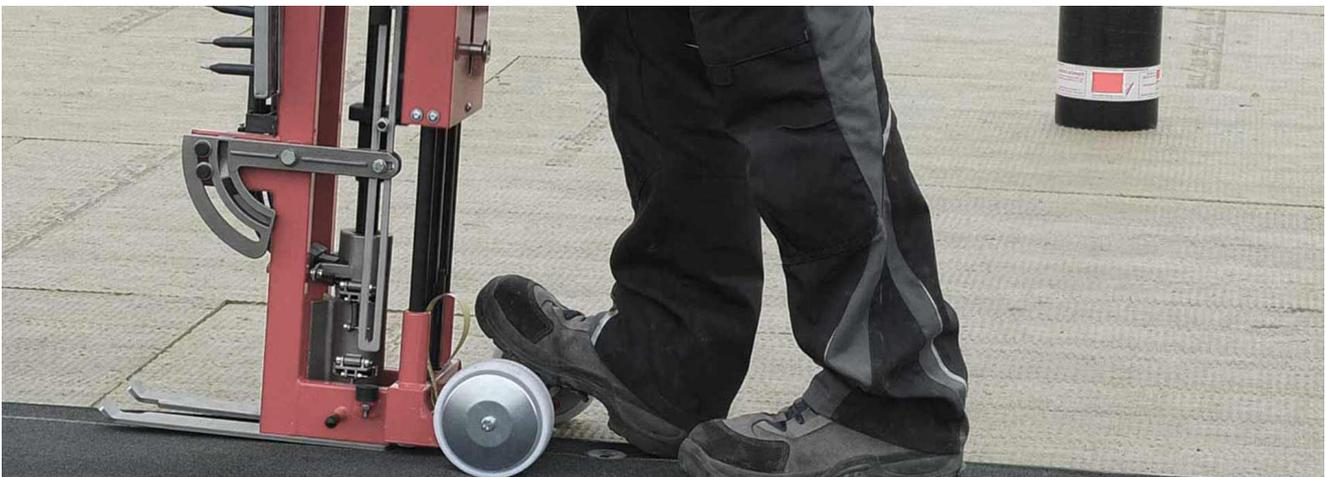
Bei der Lagesicherung durch mechanische Befestigung gibt es viele Vorteile hinsichtlich der vorherig genannten Systeme. So existieren bei der Verarbeitung keine Einschränkungen hinsichtlich Temperatur, Witterung, Oberflächenbeschaffenheit oder der Gebäudenutzung. Auch im Hinblick auf die Brandlast ist nach DIN 18234, der sogenannten Industriebaurichtlinie, die Verwendung von mechanischen Befestigern im Gegensatz zu geklebten Aufbauten ohne Nachweis zulässig. Das gesamte Dach-
