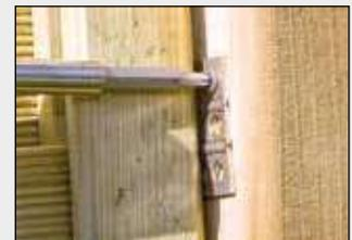
Befestigen Sie nun das Zaunfeld durch den Beschlag am Holzpfosten. Wir empfehlen pro Beschlag 4 Clickyfix-Schrauben einzusetzen
