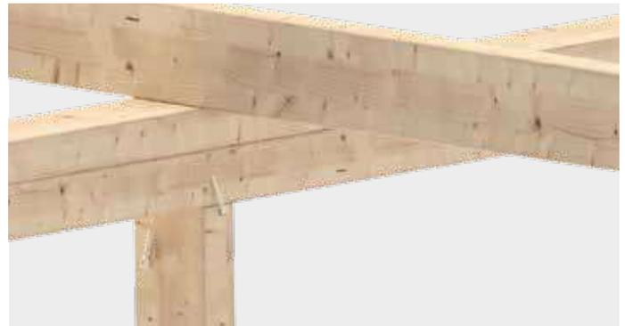
Befestigung von Stützen bei Holz-Rahmenkonstruktionen
