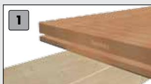
1 Verlegen Sie die erste Terrassendiele mit dem richtigen Abstand zum Haus und bohren Sie an der äußeren Kante. Die Terrassendiele kann dann an der Holzunterkonstruktion befestigt werden.
