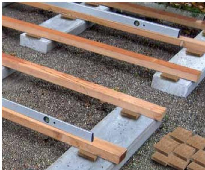
Die Kork-Pad Abstandhalter werden zwischen die Terrassenunterkonstruktion und das Fundament / den Untergrund gelegt und bilden so einen Abstand, der dem konstruktiven Holzschutz dient.
