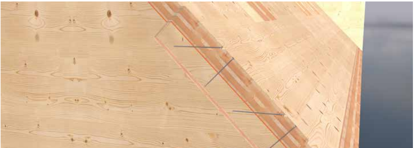
Verbindung von Dach- und Wandelement.
