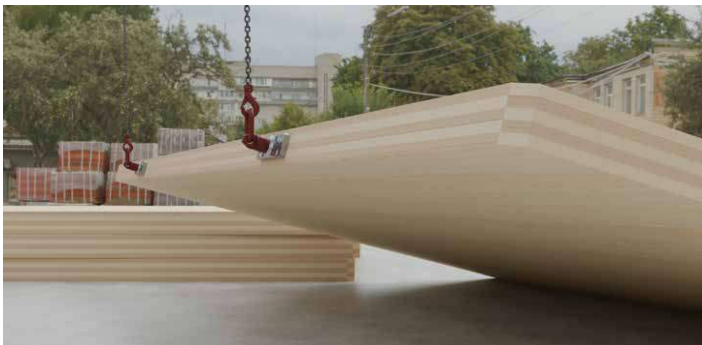
Anwendung Powerblock Transportanker
