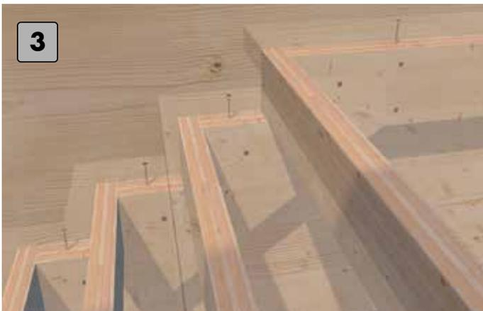
Stufen oben auf der Stufenauflage anbringen.
