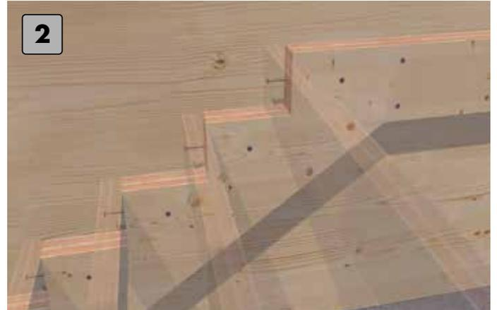
Stufenabschluss frontal an der Stufenauflage anbringen.
