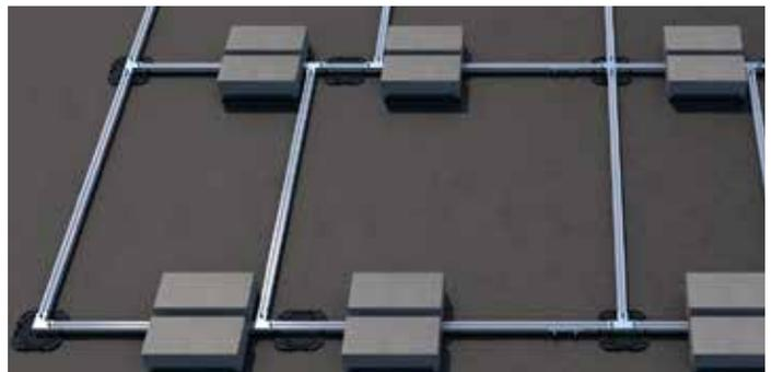
**SCHRITT 2:** Positionieren Sie die Ballastwannen, um eine möglichst gleichmäßige Verteilung der Lasten zu ermöglichen (mehr Infos finden Sie in der Montageanleitung).
