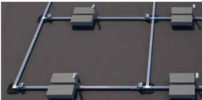
**SCHRITT 3:** Ist das Grundgerüst aus Modulfeldern fertig, können Sie die Modulaufständerungen festschrauben.
