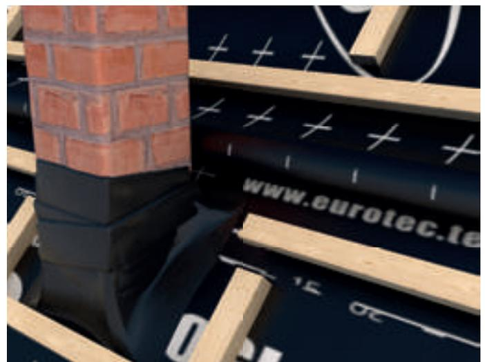
Beispielhafte Dachkonstruktion mit der verbauten Eurotec Unterdeck- / Unterspannbahn Top 180.
