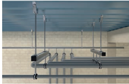
Abhängung an Trapezdecken
