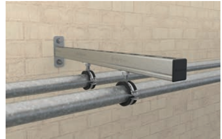
Rohrbefestigung an Konsole
