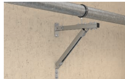
Stahlrohr stehend auf Schwerlastkonsole
