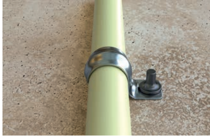
Befestigung von Panzerrohren
