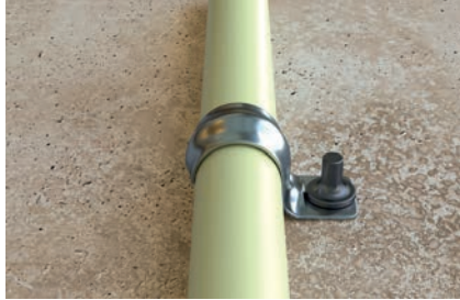
Befestigung von Panzerrohren
