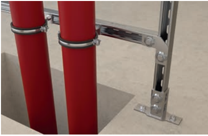
Abflußrohrbefestigung im Steigstrang
