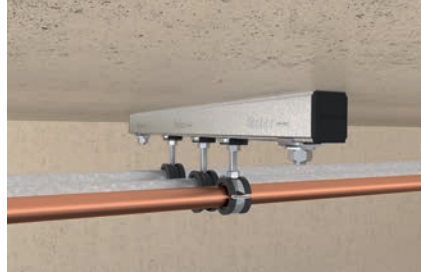
Rohrbefestigung an Montageschiene
