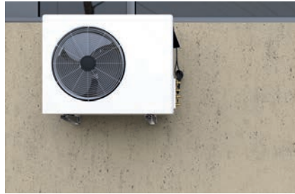
Klimagerät an Außenwand
