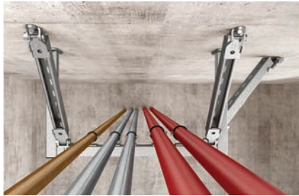
Aussteifung einer Rahmenkonstruktion mit Montageprofilen
