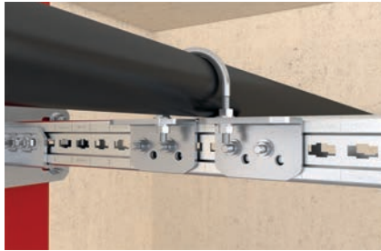
Profiltraverse an Stahlbau
