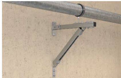
Stahlrohr stehend auf Schwerlastkonsole
