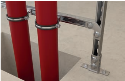
Abflußrohrbefestigung im Steigstrang
