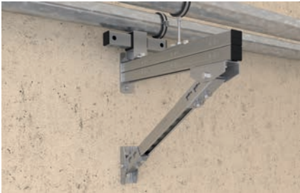
Massive Abstützung von Konsolen
