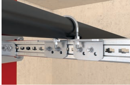
Profiltraverse an Stahlbau
