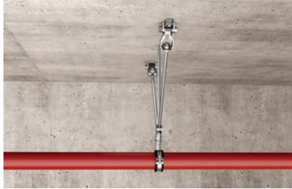
Aussteifung einer Rohrleitung mit Gewindestangen
