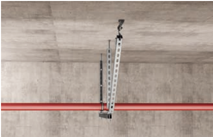
Aussteifung einer Gewindestange unter Druckbelastung
