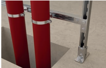
Abflußrohrbefestigung im Steigstrang
