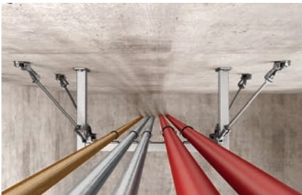
Aussteifung einer Rahmenkonstruktion mit Gewindestangen
