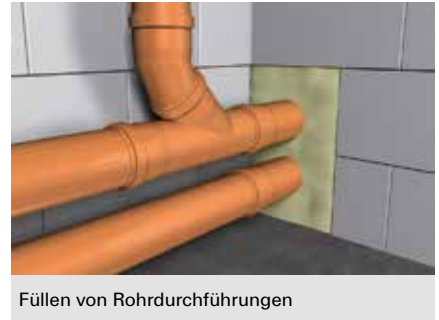
Dämmen und Füllen von Mauerdurchbrüchen
