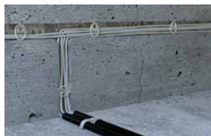
Kabelbefestigung in Wandschlitzzen < 55 mm
