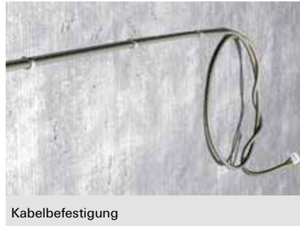
Befestigung flexibler Leerrohre
