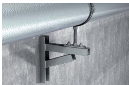
Stahlrohr stehend auf Schwerlastkonsole
