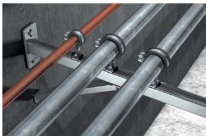
Rohrbefestigung entlang der Wand
