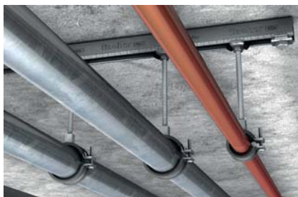
Rohrbefestigung an Montageschiene
