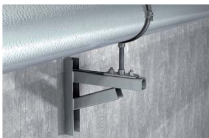
Stahlrohr stehend auf Schwerlastkonsole
