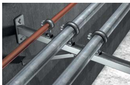
Rohrbefestigung entlang der Wand
