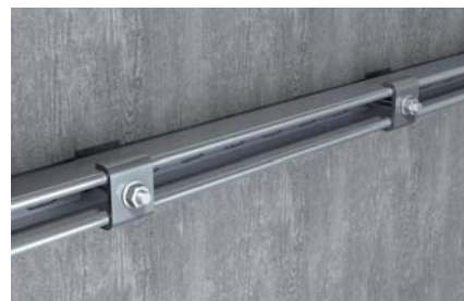
Schienenmontage an Wand
