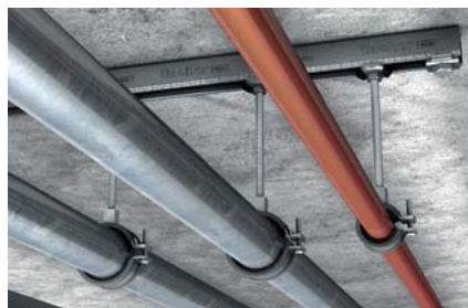
Rohrbefestigung an Montageschiene
