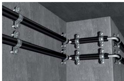
Befestigung von Stahlpanzerrohren
