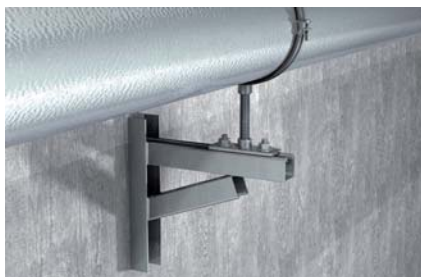
Stahlrohr stehend auf Schwerlastkonsole
