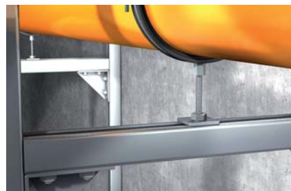
Rohrbefestigung auf Schiene
