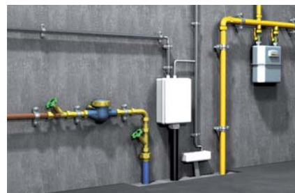
Befestigung von Leitungen
