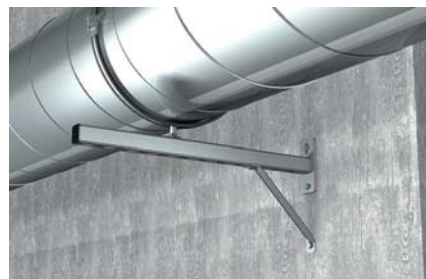
Lüftungsrohrbefestigung an der Wand
