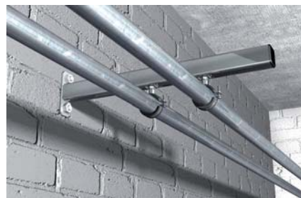
Rohrbefestigung an Konsole
