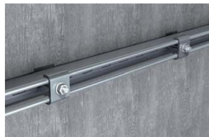
Schienenmontage an Wand
