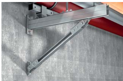
Massive Abstützung von Konsolen
