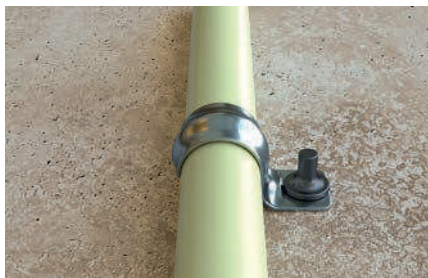
Befestigung von Panzerrohren
