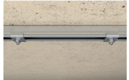
Schienenmontage an Decke
