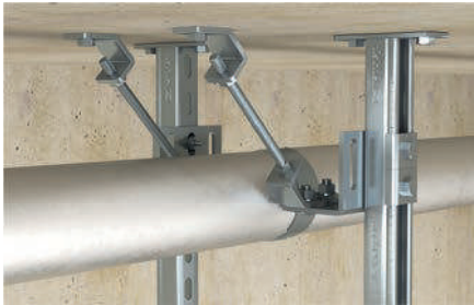
Rohraussteifung in Längsrichtung mit FTRB 45
