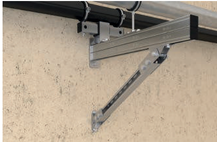
Massive Abstützung von Konsolen
