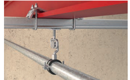
Schiene an Stahlträger
