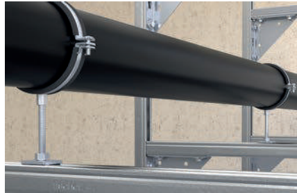
Rohrbefestigung auf Schiene
