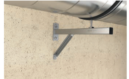
Lüftungrohrbefestigung an der Wand
