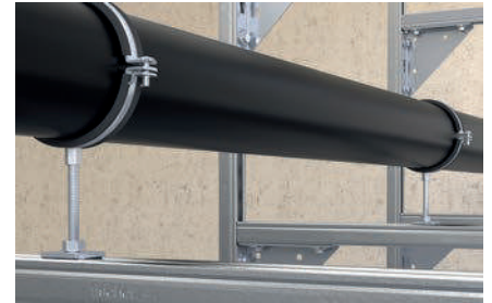
Rohrbefestigung auf Schiene
