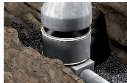
Abdichten von Beton-Schachtringen
