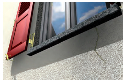
Schließen von Mauerwerksrissen im Außenbereich
