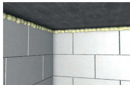
Schließen von Fugen im Rohbau
