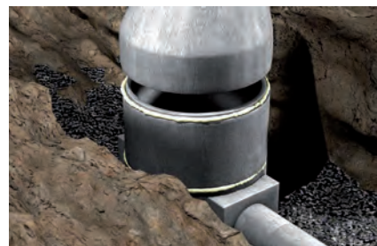
Abdichten von Beton-Schachtringen
