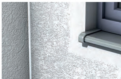
Anschlussfugen im Außenbereich
