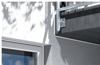
Anschlussfugen im Außenbereich
