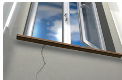
Schließen von Mauerwerksrissen im Innenbereich
