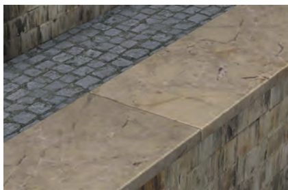
Mauerkopfabdeckungen
