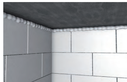
Schließen von Fugen im Rohbau
