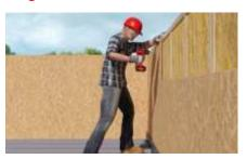
Für die Verarbeitung der PowerFast II Holzbauschraube kann auch ein Tangentialschlagschrauber verwendet werden.
