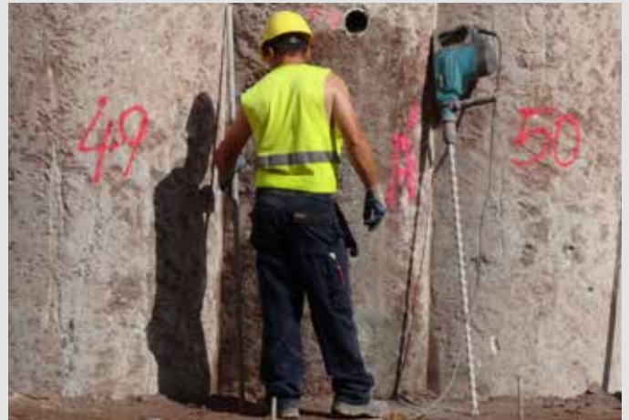
Bohrer mit einer Arbeitslänge bis 2.000 mm speziell für nachträgliche Bewehrungsanschlüsse
