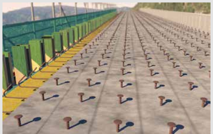
Beton-Beton Schubverbinder zur Verstärkung
