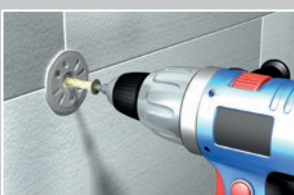
Geschraubter Dübel auf Polystyrol Platte
