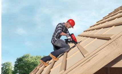
Das schnelle Befestigen mit bis zu drei Nägeln pro Sekunde ermöglicht es, Arbeiten in kurzer Zeit zu erledigen
