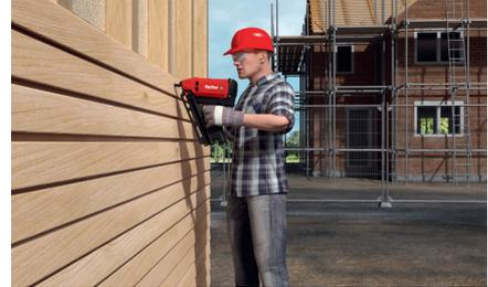
Die beigefügte Kappe dient zum Schutz der Holzoberfläche in sichtbaren Bereichen, z. B. bei Außenverkleidungen
