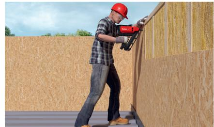
Das FGW 90F ist geeignet für Beplankungen mit OSB-Platten
