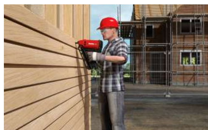
Anbringung von Außenverkleidungen
