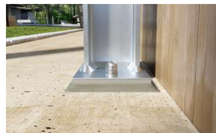
Verankerung von Stützen
