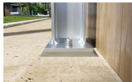
Verankerung von Stützen
