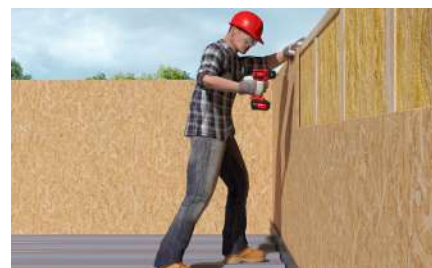
Befestigung von OSB-Platten auf Holzständern im Holzrahmenbau
