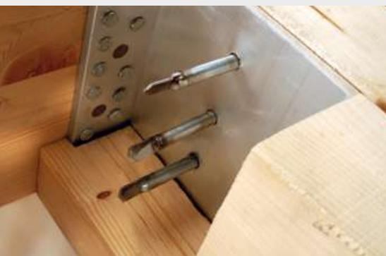
**Ausführung:** HECO-WS Selbstbohrender Stabdübel, Zylindersenkopf
