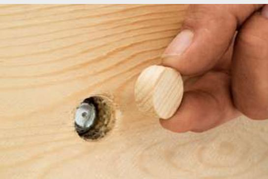
**Ausführung:** **A** HECO-WB Gewindestange **B** mit M16-Anschlussgewinde
