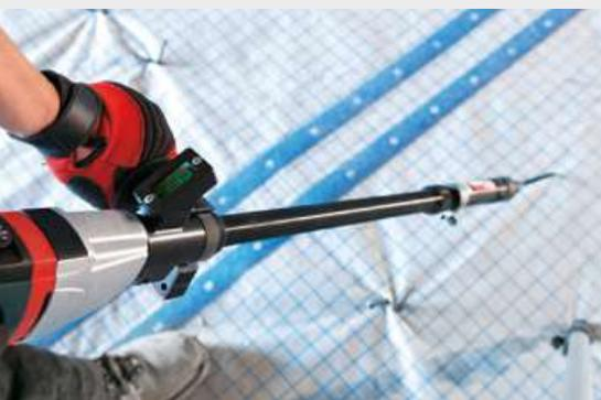
**Ausführung:** HECO-VB Holz-Beton-Verbundschraube, Spezial-Kopf
