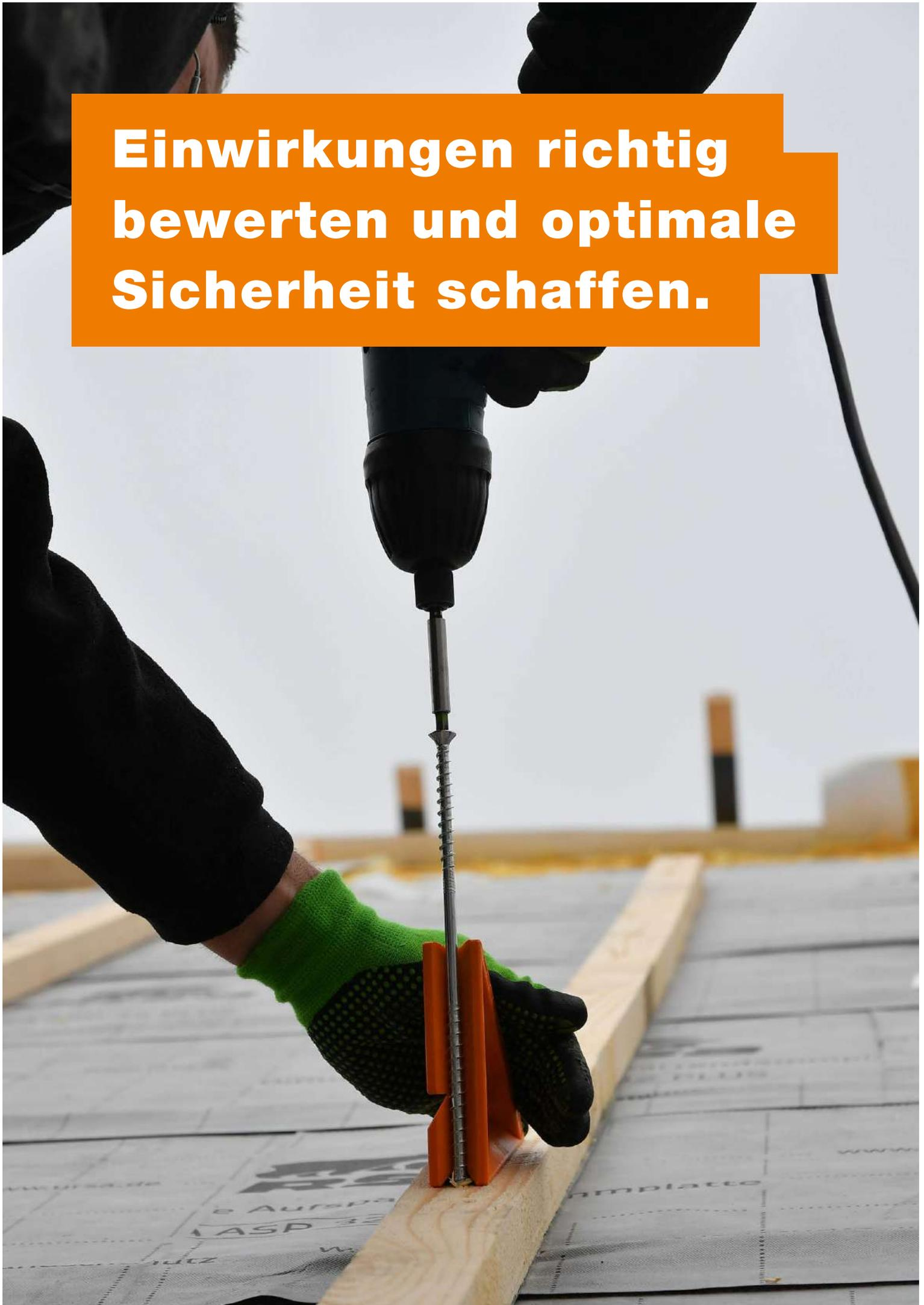
Bei der Ausführung und Planung von Aufdachdämmsystemen müssen verschiedenste Gesichtspunkte betrachtet werden. Einwirkungen aus Eigengewicht, Schneelast und Windkraft (Windsog + Winddruck) können in lotrechte und rechtwinklige Kräfte eingeteilt werden. Sie sind für jedes Projekt individuell zu bewerten. Zusatzaufbauten, wie PV-Anlagen und Schneefanggitter dürfen dabei nicht außer acht gelassen werden.
