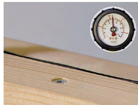
**Bei der Montage dickerer Anbauteile führt die Fixierung mittels Gewinde zu einer deutlich höheren Belastbarkeit der Verbindung. Das spart Montagepunkte und/oder führt zu höherer Sicherheit.**
