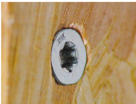
**Das HECO-UNIX-Vollgewinde mit veränderlicher Steigung zieht die Bauteile schon beim Verschrauben zusammen. Das tiefe Versenken des Kopfes ist daher nicht notwendig.**
