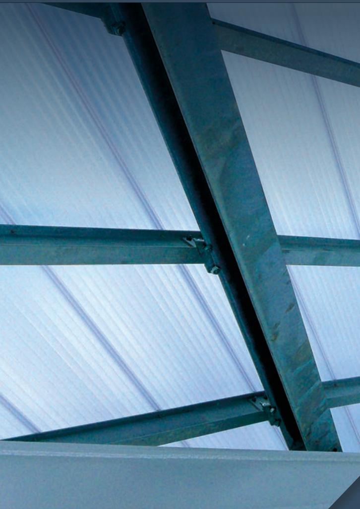
Hinter der Fassade eines Bauwerks befindet sich oft ein sekundärer Stahlbau. Lindapter-Trägerklemmen bieten eine schnellere Alternative zu traditionellen Verbindungsverfahren und sind mit fast jeder Profilform und -größe bei verschiedensten Anwendungen kompatibel.
