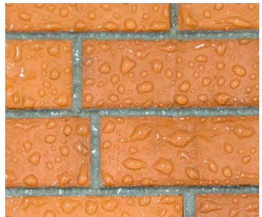
Hydrophobierte Fassade mit OTTO Siloxan 290L
