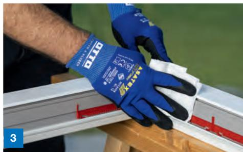
3 Vorbereitung der Klebfläche des Profils mit OTTO Cleanprimer (bzw. Cleaner + Primer)<sup>1)</sup>
