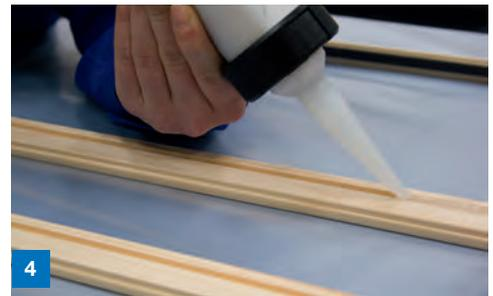
4 **Oder:** Abdichtung zwischen Flügelrahmen und Glashalteleiste flächig
