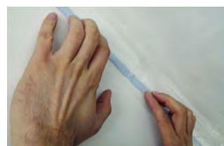
2. Entlastungsschleife in Dampfsperre legen, da diese Baubewegungen aufnimmt.
