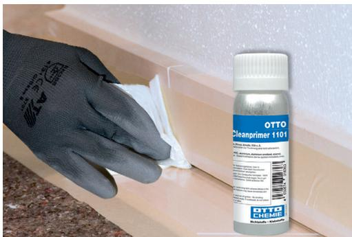
**3. Grundieren** der Haftflanken mit dem passenden Primer oder z.B. OTTO Cleanprimer 1101 u.a. für Sanitär-Acryl. Der Auftrag von dem Primer auf glatten, nicht saugenden Untergründe sollte mit einem sauberen Tuch und auf saugenden Untergründen mit einem Pinsel erfolgen.
