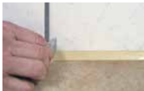
Fugenboy mit Glättmittel benetzen und abziehen
