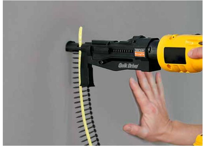
Montage einer Gipskartonplatte an Holzständerwerk mit DWC-Schnellbauschrauben
