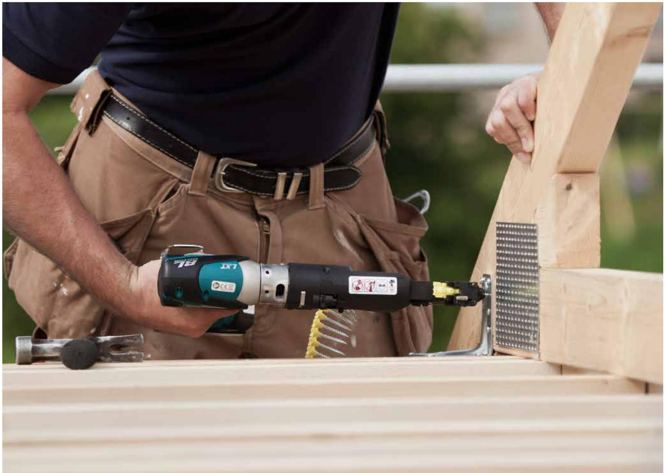
Montage eines ABR90 Winkelverbinders mit Quik Drive® Magazinschraubensystem.
