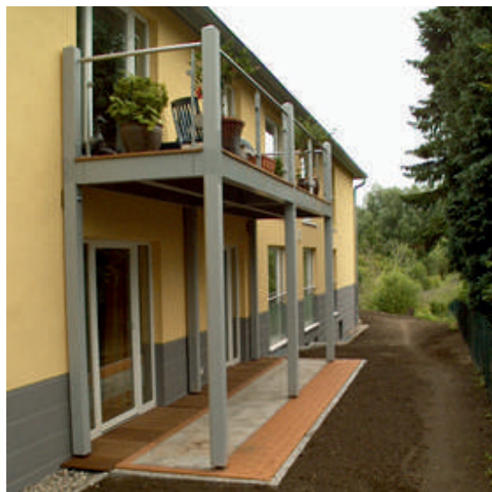
Balkonanlage mit offenem Belag in Nutzungsklasse 3
