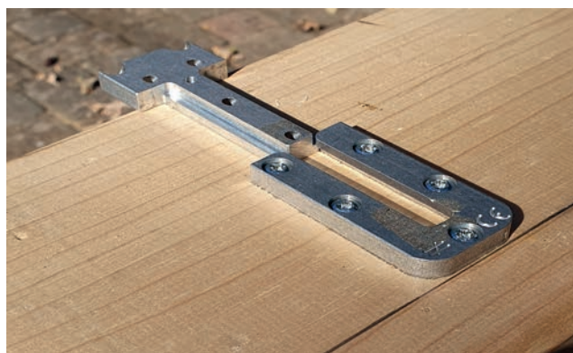
Bild 3 Der zweite Verbinderteil lässt sich nicht mehr einschieben, Nacharbeiten werden nötig
