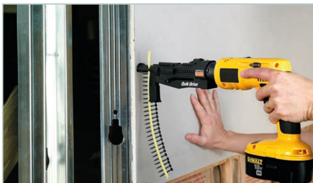
Montage von Gipskartonplatten auf Metallständerwerk
