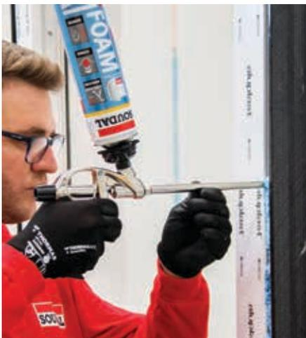
**15** Federclipse entfernen und Fenster abdichten
