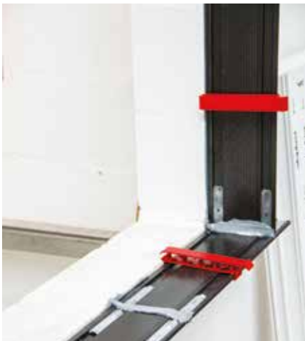
12 Ecken abdichten und Federclipse positionieren
