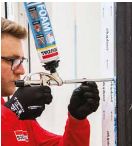
15 Federclipse entfernen und Fenster abdichten
