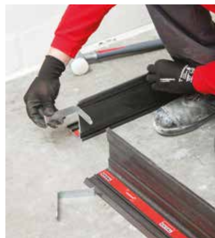
03 Eckverbinder befestigen
