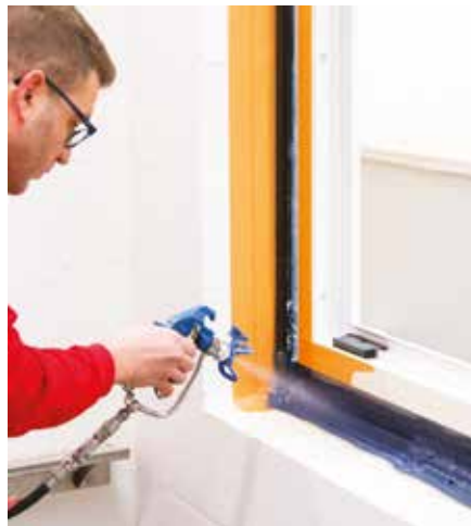
16 Fensterabdichtung Innen Soudatight LQ/SP
