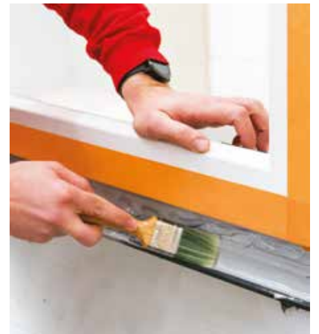
17 Fensterabdichtung Außen Soudatight Hybrid
