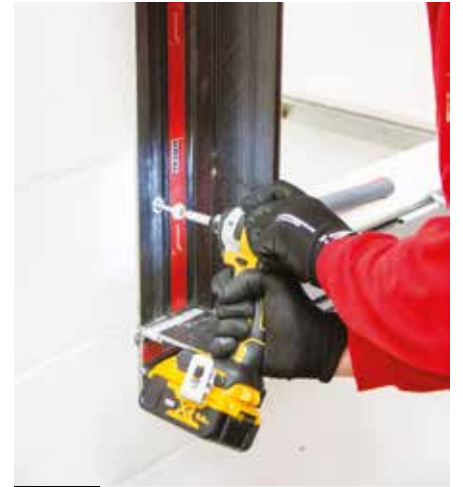
11 Rahmendübel anbringen und einschrauben
