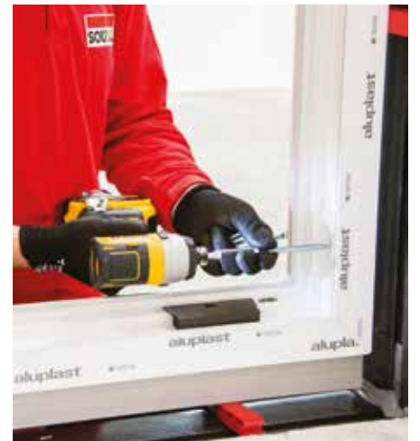
14 Fenster mechanisch befestigen
