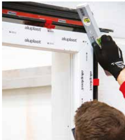
13 Fenster vorbohren, einsetzen und ausrichten
