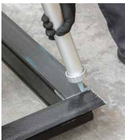
07 Klebstoff auf alle Verbindungen aufbringen
