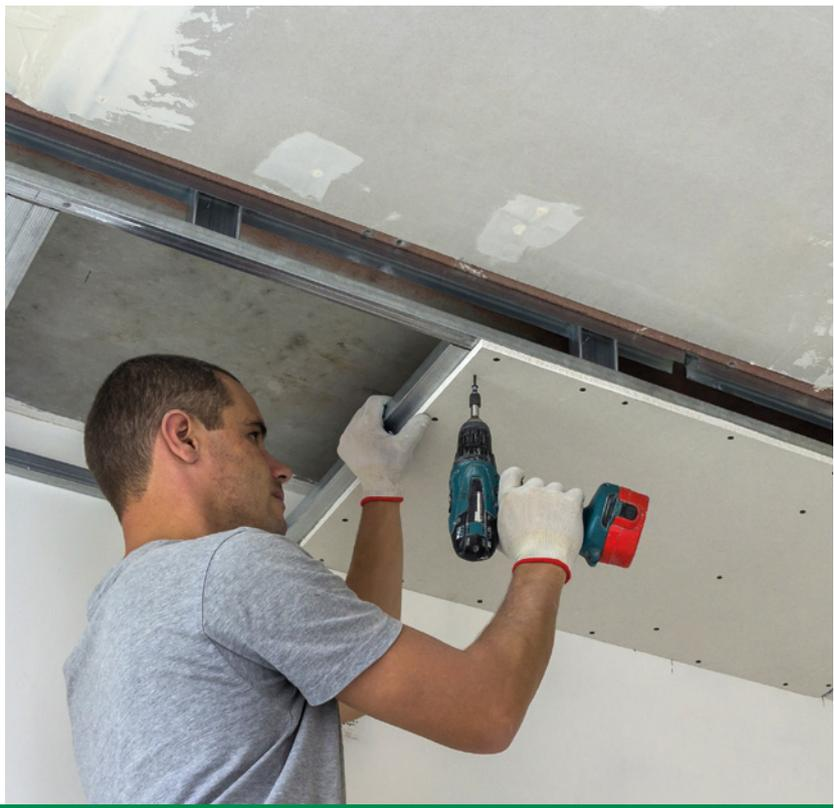
Für jede erdenkliche Materialkombination im Trockenbau haben wir die passenden Schrauben im Programm, die bei uns den Namen GIX® tragen. Deren auffällige schwarze Färbung ist Folge einer Phosphatierung, ein Korrosionsschutz, der dafür sorgt, dass die Schrauben
