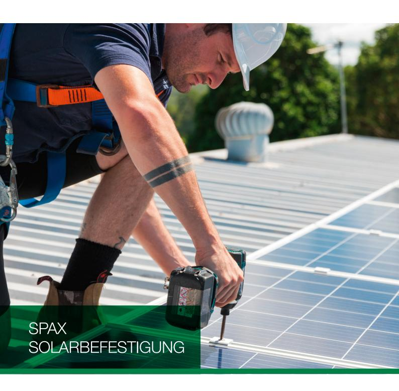
SPAX Universal und Holzbauschrauben aus Edelstahl rostfrei A2 - die Lösung für die Befestigung von PV Anlagen bei einer Aufsparrendämmung. Die Montage kann direkt in die Konterlatte erfolgen, es muss lediglich bei der Berechnung der Aufsparrendämmung die Dachlast um das Gewicht der PV Anlage erhöht werden (ca. 0,2kN).
